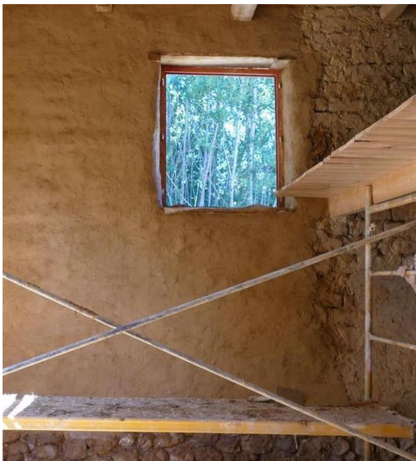
Muro de adobe en proceso de reparación
