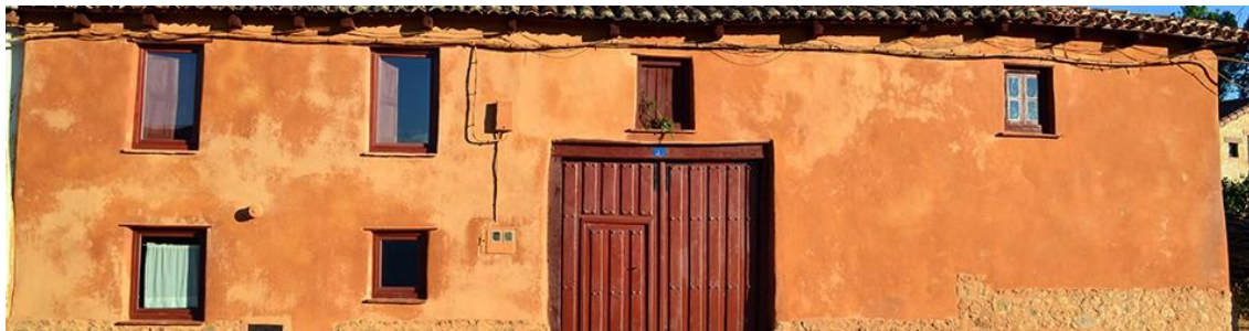
Fachada de barro de La provisional. Barrillos de Curueño.
